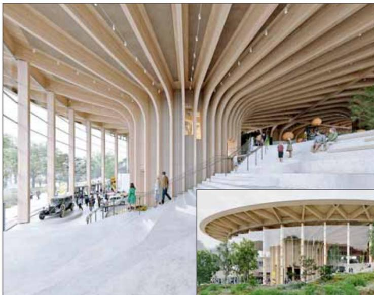
Das Holztragwerk der Erlebniswelt „World of Volvo“ lehnt sich an die Gestalt von Bäumen an: Zu Halbröhren ausgebildete Brettschichtholz-Stützen und -Träger mit ausgerichteten Rahmenecken prägen das Bild. Visualisierungen: Kvant-1 (2)
