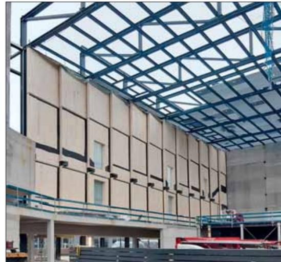
Die großformatigen Brettsperrholz-Wandelemente wurden per Kran durch das offene Dach eingefädelt und an der Stahlkonstruktion der Halle befestigt. Foto: Züblin Timber
