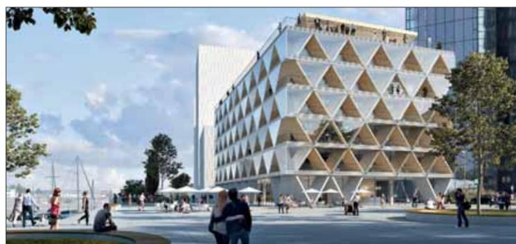
Das inzwischen fertiggestellte „The Cradle“ steht in Düsseldorf und gilt als Pionierprojekt. Die rautennetzähnliche Gitterstruktur der Gebäudehülle bilden V-Stützen unterschiedlicher Geometriertypen – eine planerische Herausforderung für Grafik: HPP Architekten/Bloomimages
