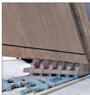
Demontierbare „Baubuchen“-Knagge mit speziellem Stahlanschlusssteil zur Lastweiterleitung. Foto: Derix-Gruppe
